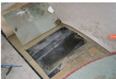
Rys. 9. Zastoina wody na warstwie folii
