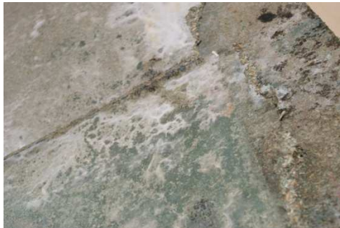
Rys. 8. Ślady porażenia grzybami-pleśniami na powierzchni płyty włórowej, w warstwie kleju
