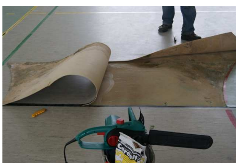
Rys. 7. Odkrywka w posadzce sali
