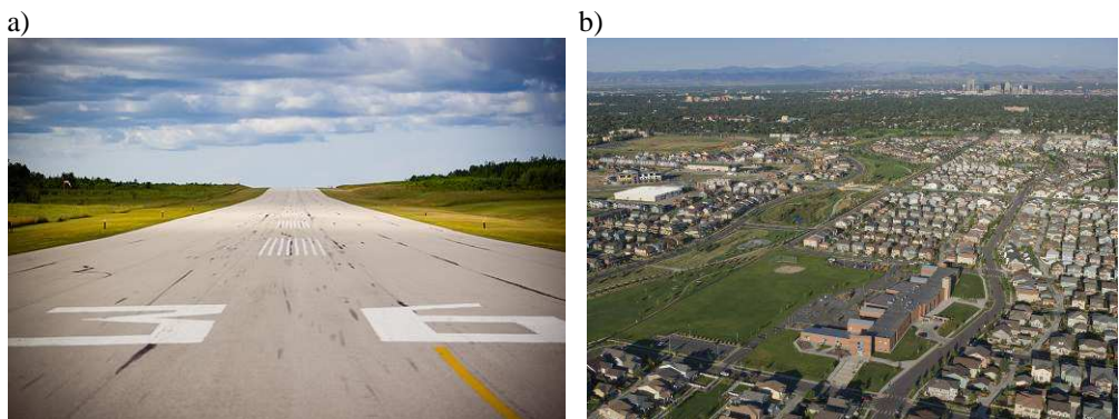
Rys. 1. Nieistniejące już lotnisko w Denver: a) widok betonowego pasa startowego lotniska przed rozbiorą, b) widok osiedla powstałego w bezpośrednim sąsiedztwie byłego lotniska, w którym wykorzystano beton z recyklingowanych betonowych płyt lotniska
