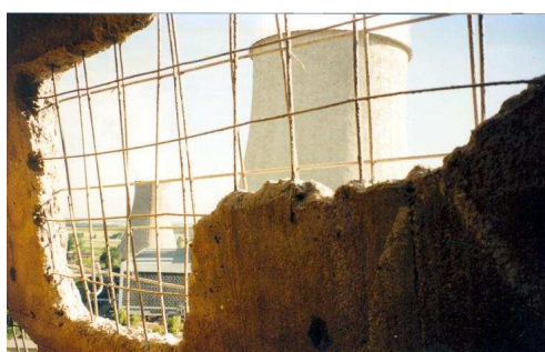
Rys. 9. Usuwanie skorodowanego betonu (tzw. okna) Rys. 10. Stan zbrojenia we wykutym oknie
