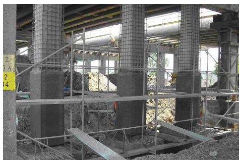
Rys. 2. Wzmacnianie słupów
