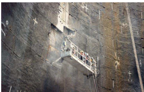
Rys. 9. Usuwanie skorodowanego betonu (tzw. okna) Rys. 10. Stan zbrojenia we wykutym oknie
