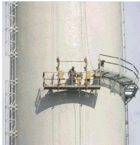
Rys. 8. Nanoszenie powłok ochronnych i montaż galerii środkowej
