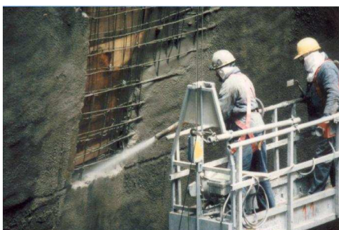
Rys. 11. Natryskiwanie betonu
