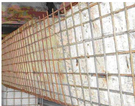
Rys. 3. Montaż zbrojenia na belce oczepowej
