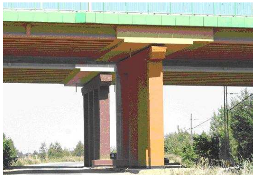
Rys. 4. Wiadukt po naprawie i wzmocnieniu
