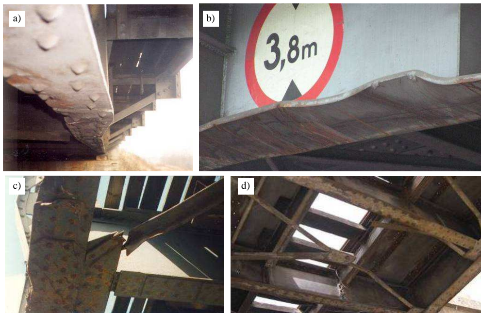
Rys. 5. Typowe uszkodzenia przęseł mostowych spowodowane uderzeniami samochodów przejeżdżających pod obiektem: a) deformacja osi dźwigara, b) deformacja dolnego pasa dźwigara, c) pęknięcie elementu stężenia, d) pęknięcie i deformacja elementów stężenia
