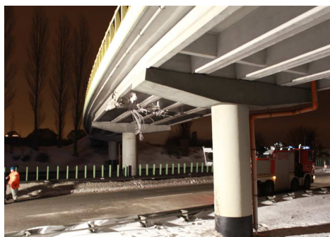
Rys. 1. Widok ogólny uszkodzonego przęsła bezpośrednio po uderzeniu
