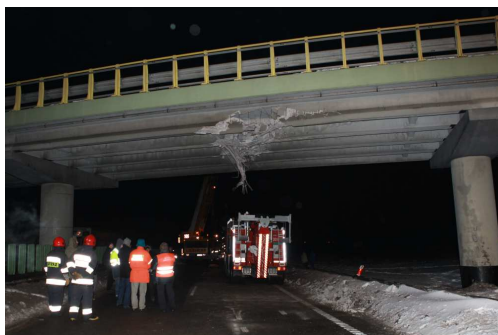
Rys. 1. Widok ogólny uszkodzonego przęsła bezpośrednio po uderzeniu
