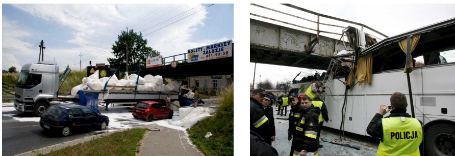
Rys. 2. Z lewej uderzenie ciężarówki w wiadukt w Nowym Sączu (źródło: wiadomosci24.pl), z prawej uderzenie autobusu w wiadukt w Świdnicy (źródło: PAP)
