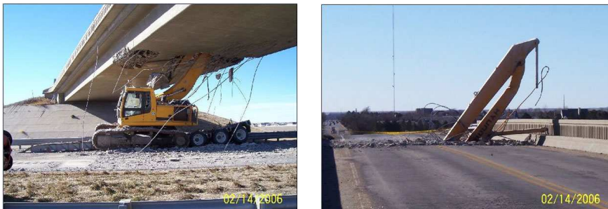
Rys. 1. Przykład kolizji pojazdu z konstrukcją mostu (źródło: dailycognition.com)
