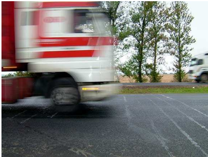
Rys. 1. Elementy pomiarowe stacji WIM ukryte w jezdni
