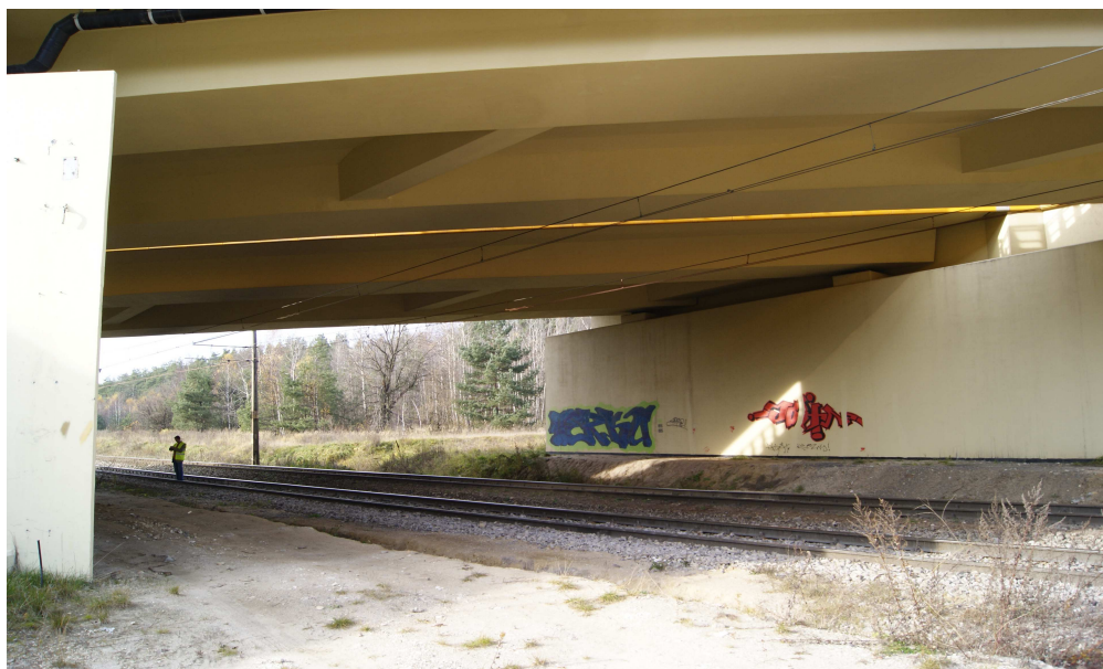
Rys. 3. Widok badanego wiaduktu WD-1 nad linią kolejową
