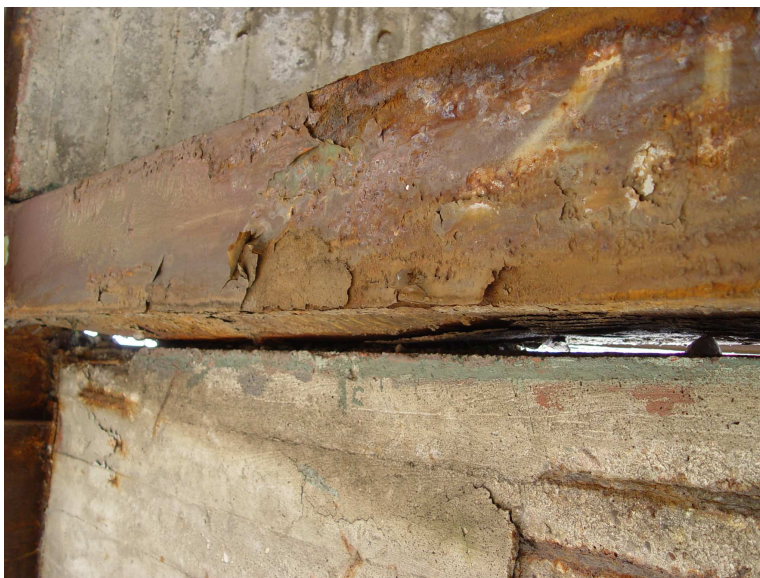
Rys. 6. Dźwigar schodów z wybrzuszoną średnicą
