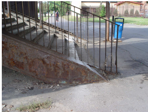
Rys. 3. Zagłębienie fundamentu
