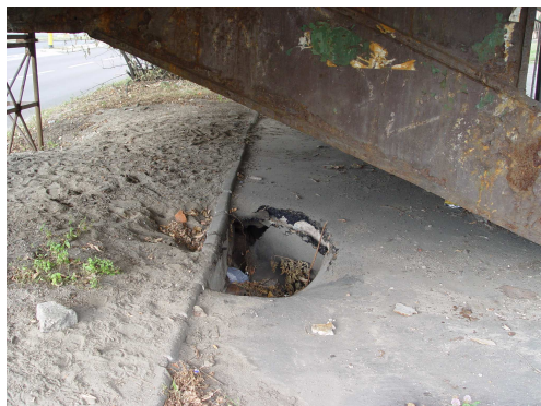
Rys. 2. Zapadnięcie nawierzchni
