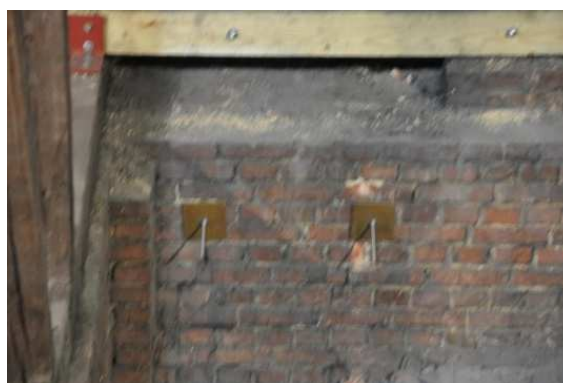
Rys. 12. Naprawiony gzyms – widok od wewnątrz
