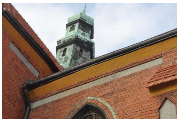
Rys. 11. Naprawiony gzyms – widok od zewnątrz
