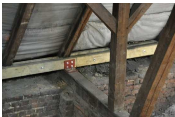
Rys. 8. Widok naprawionych murlat – nakładki oraz kątownik 160 \times 160
