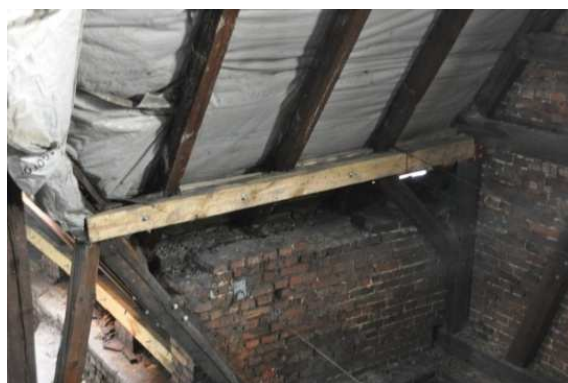
Rys. 9. Widok naprawionych murlat za pomocą nakładek i śrub
