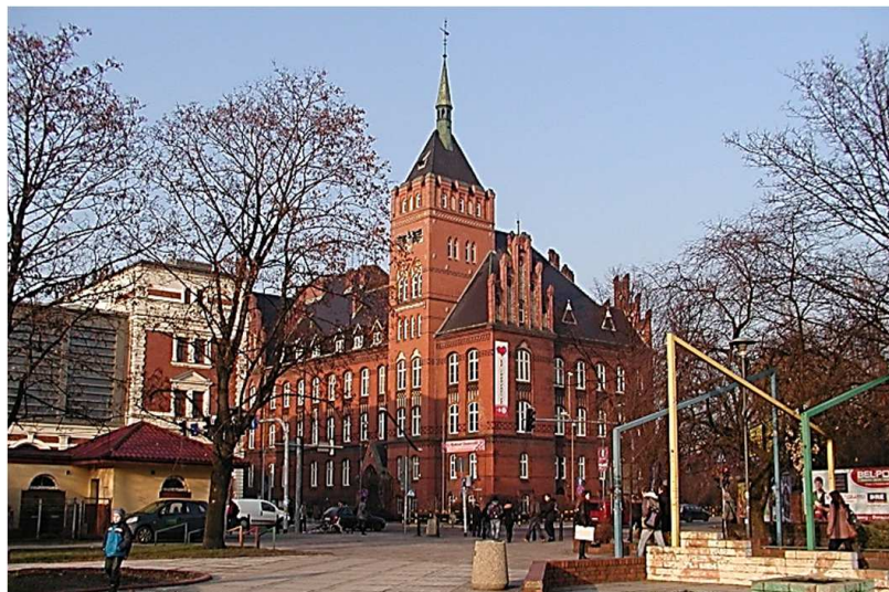
Rys. 2. Widok ogólny budynku
