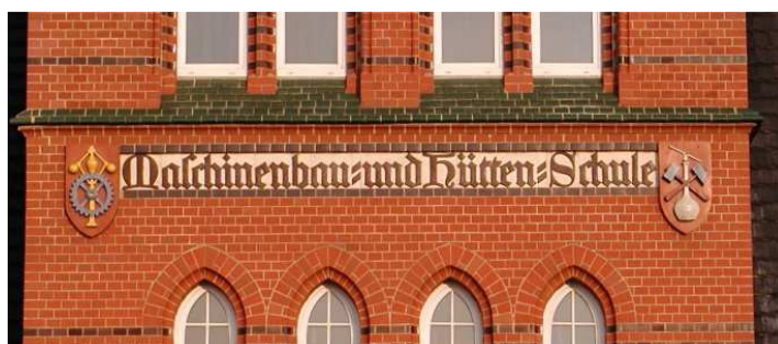
Rys. 10. Odtworzony napis „Szkola budowy maszyn i hutnictwa”
