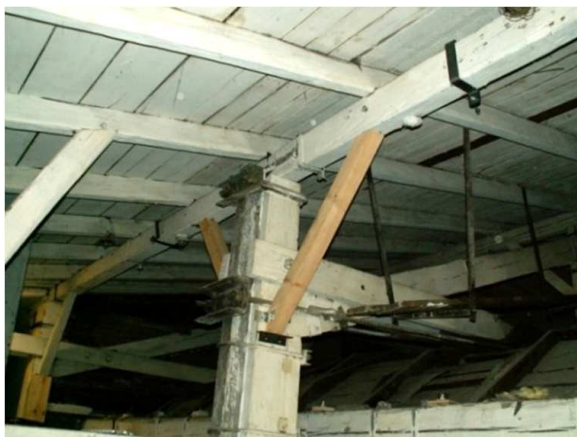
Rys. 13. Uzupełniony miecz podpierający płatów, a także wymienione podkładki
