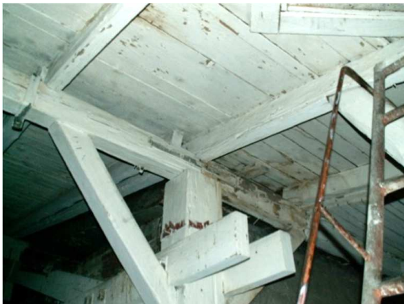
Rys. 6. Ślady wcześniejszego zalania deskowania i płatwi
