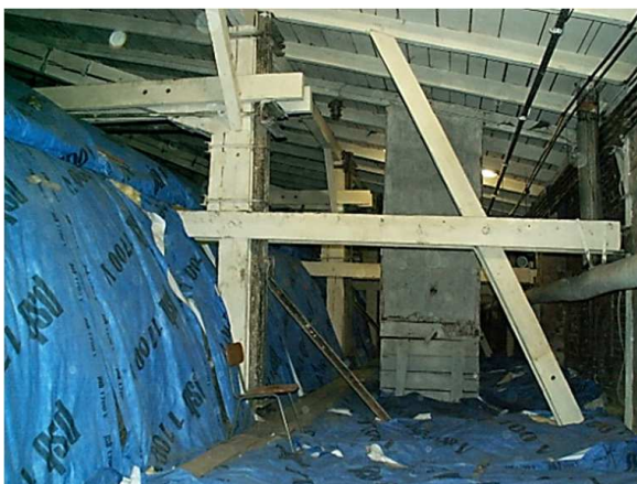
Rys. 4. Widok konstrukcji dachowej z ułożoną warstwą dodatkowej izolacji termicznej.
