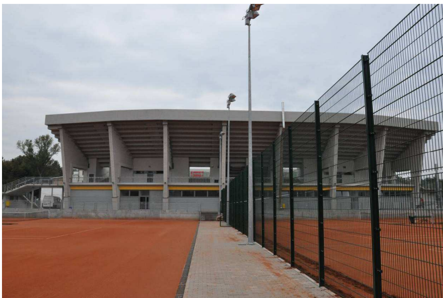
Rys. 2. Ściany podporowe (tarcze) trybun
