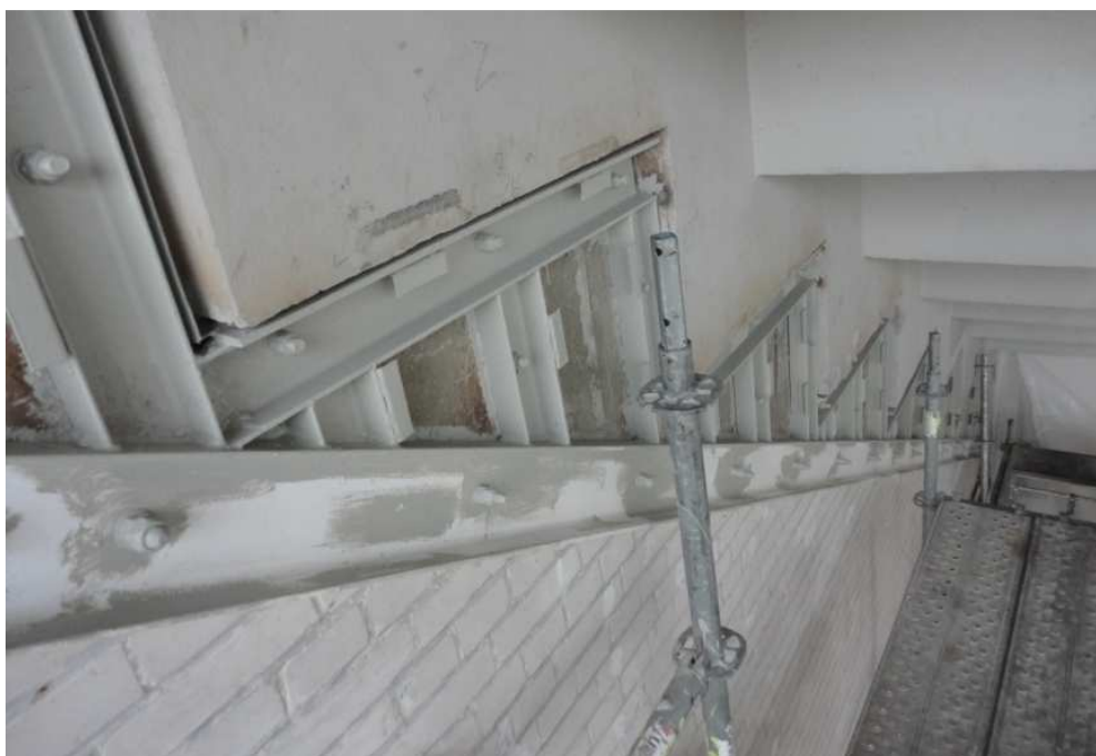
Rys. 9. Montaż stalowej konstrukcji wzmocniającej ściany podporowe
