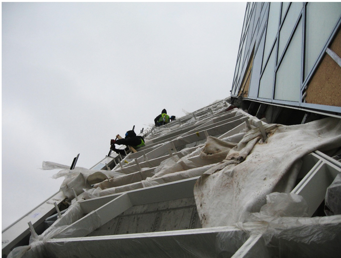
Fot. 2. Realizacja ściany/świetlika
