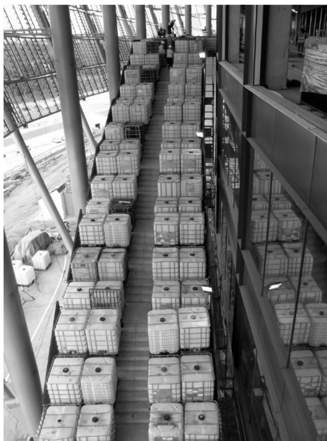
Rys. 5. Widok schodów w czasie próbnego obciążenia statycznego (fot. T. Wierzbicki)
