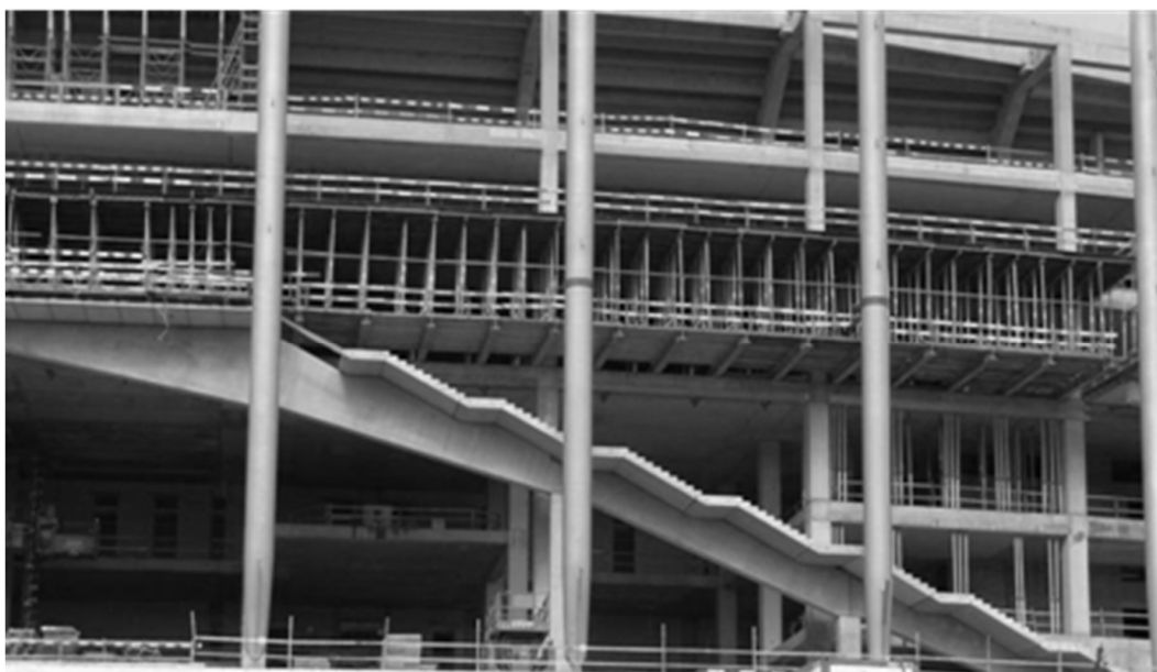
Rys. 1. Widok ogólny schodów żelbetowych w czasie budowy
