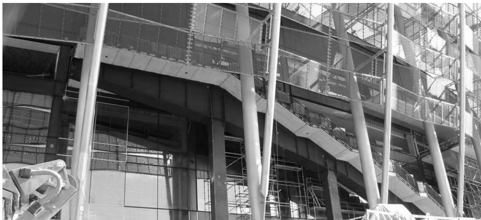
Rys. 2. Widok ogólny schodów po obudowaniu konstrukcją stalową
