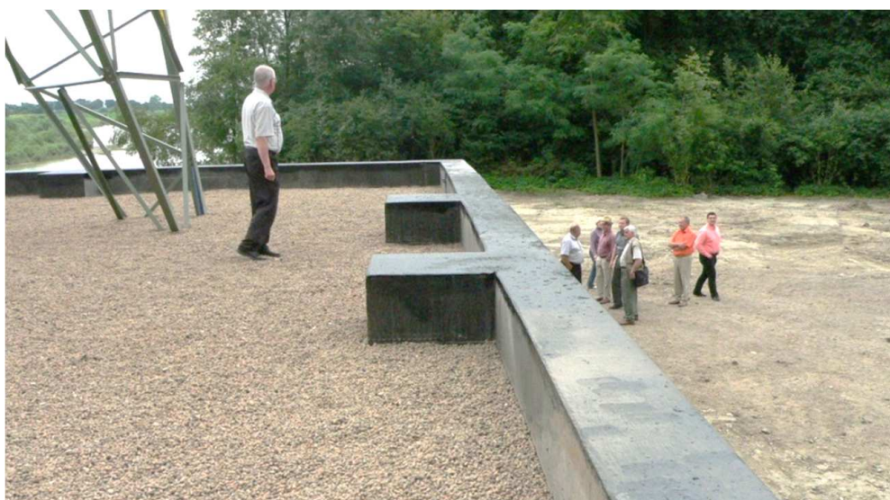
Rys. 6. Widok fundamentu słupa
