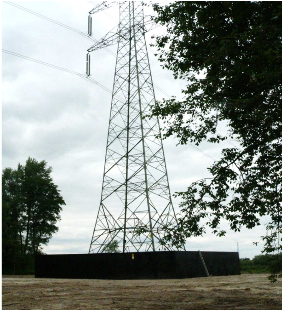
Rys. 5. Widok słupa wraz z fundamentem
