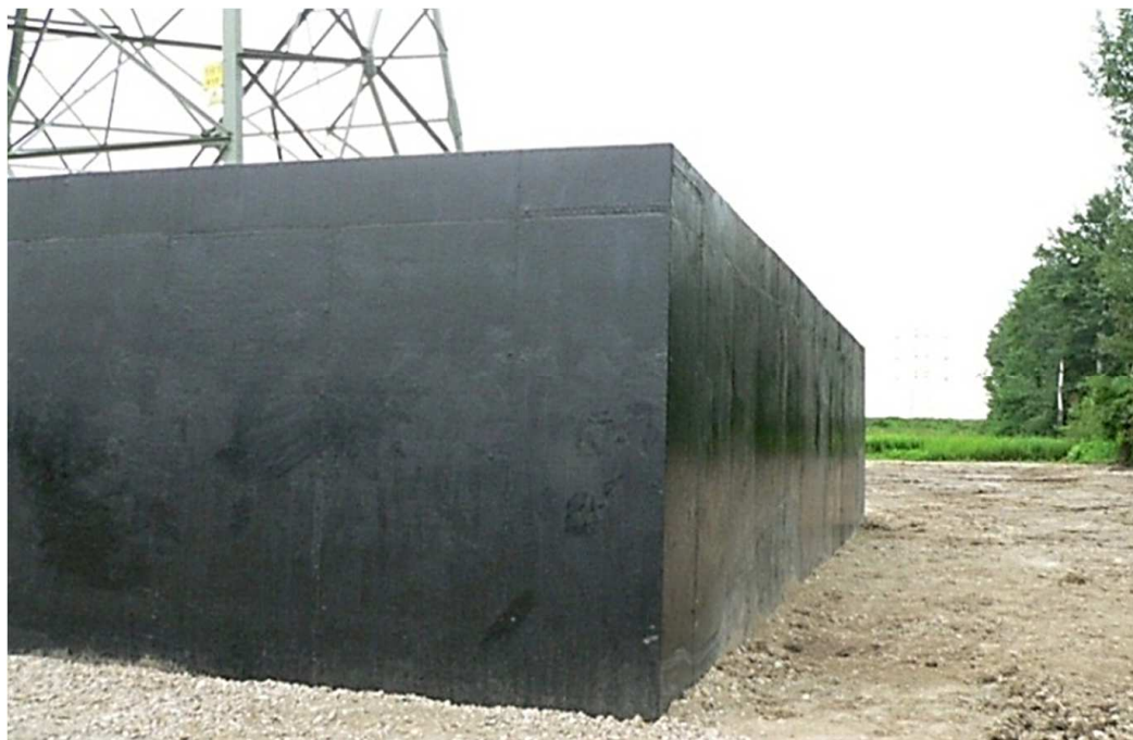
Rys. 4. Widok fundamentu po wykonaniu
