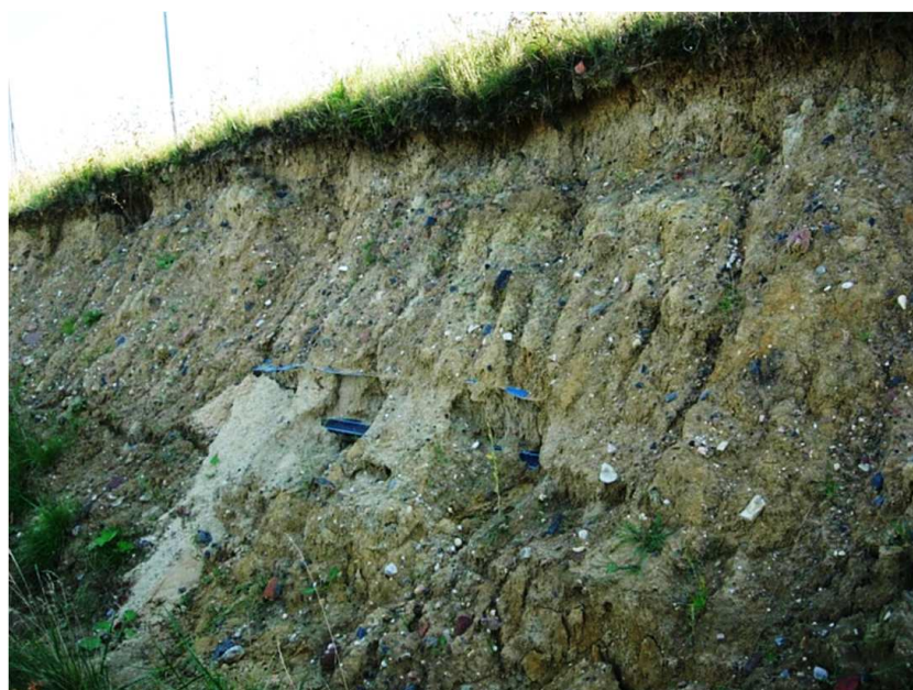
Fot. 2. Widok odsłoniętego wodociągu.
