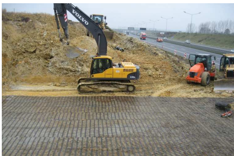
Fot. 6. Widok warstwy ułożonych georusztów o funkcji zbrojeniowej
