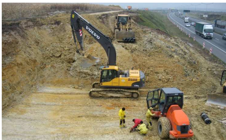
Fot. 4. Widok odcinka skarpy po usunięciu obsuniętego materiału
