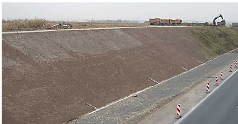
Fot. 8. Widok skarpy po naprawie
