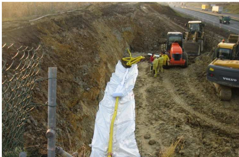
Fot. 5. Widok drenu w trakcie układania
