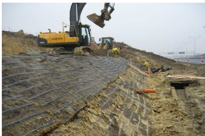
Fot. 7. Wywinięcie georusztów na licu skarpy oraz widoczne wyprowadzenie drenażu
