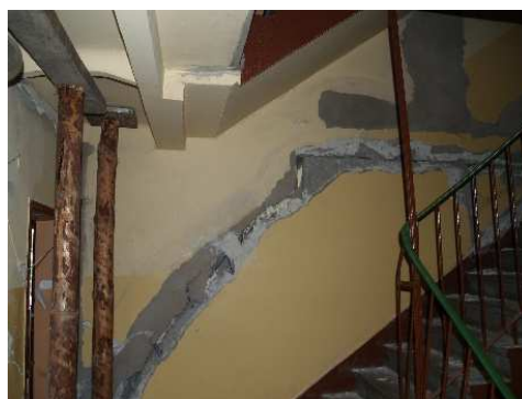
Rys. 8. Ukośne spękanie podłużnej ściany wewnętrznej segmentu nr 11 szeregu d)
