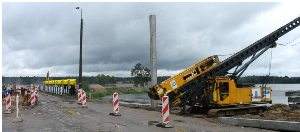
Rys. 1. Widok na maszynę palującą JUNTAN PM20, zainstalowany pal prefabrykowany i istniejący most drogowy
