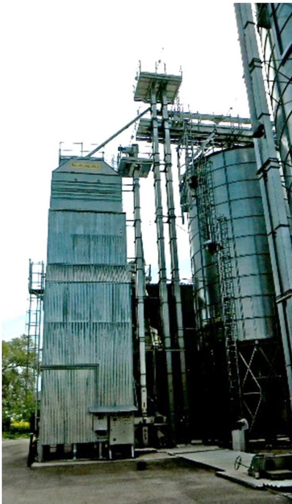
Fot. 1. Widok ogólny silosu nr 1
