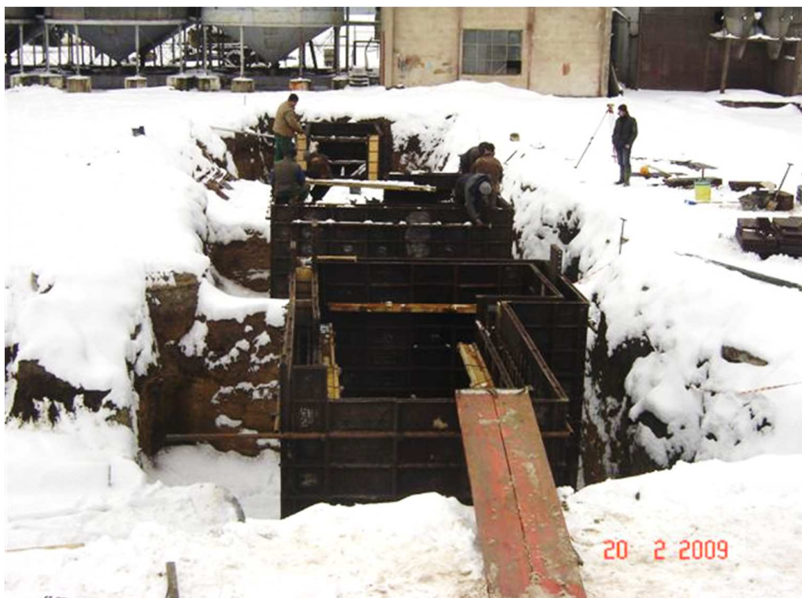
Fot. 2. Widok rozkopów wokół komór technologicznych
