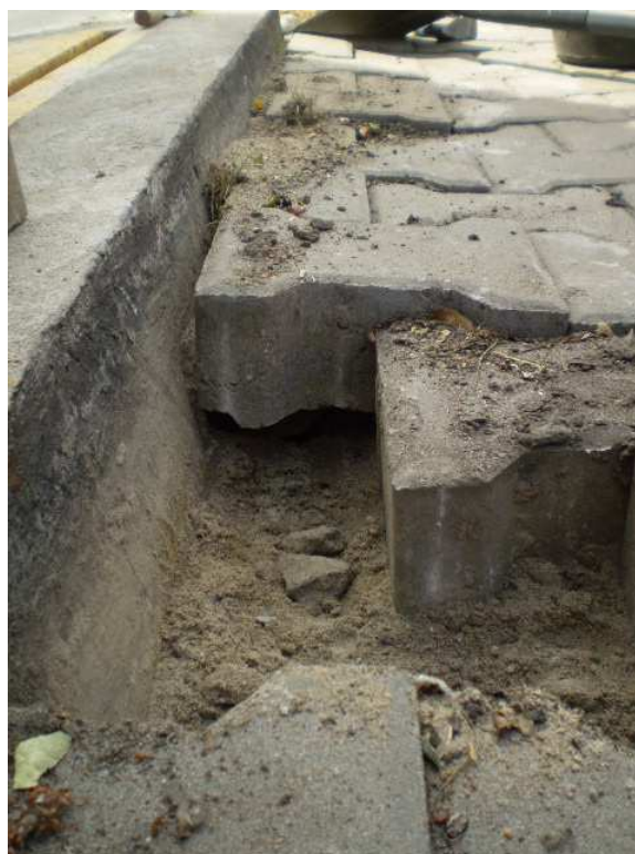
Rys. 4 Zakleszczony chodnik nad osiadającym podłożem w obszarze wyspy między wagami
