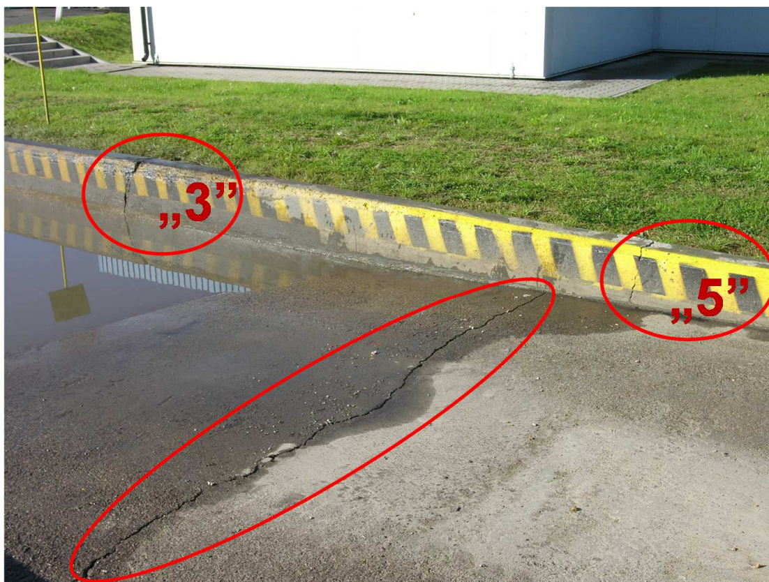
Rys. 8 Pęknięcia ściany i płyty dennej brodzika po stronie PN
