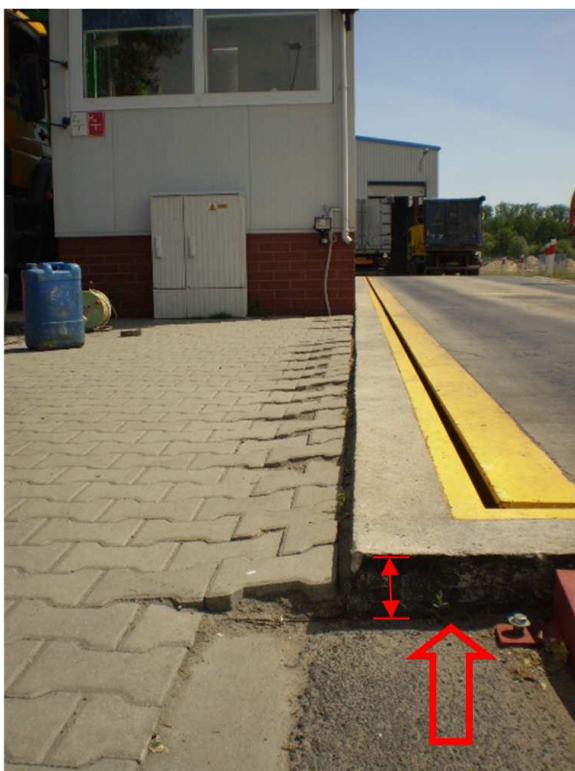
Rys. 3 Skala osiadań chodnika w stosunku do lica skrzyni wagi samochodowej – ok. 8 cm
