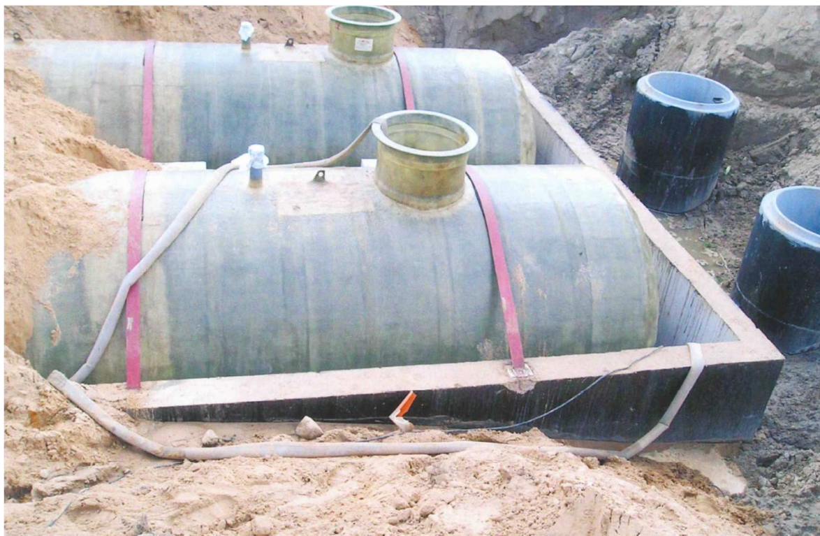
Rys. 1. Widok zbiorników TWS 2800×10000 w trakcie montażu i budowy przepompowni PP15
