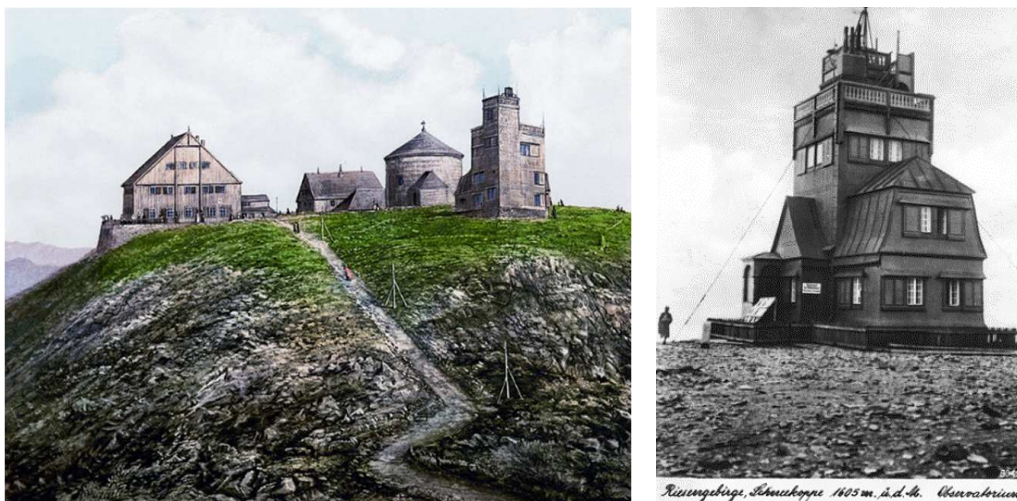
Rys. 1. Zabudowania na Śnieżce 1900 r. Budynek starego obserwatorium (źródło: internet)
