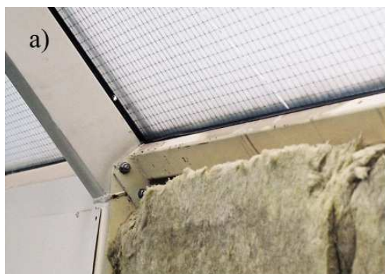
Rys. 4. Szczegóły pękniętych szyb świetlika: a) nad rygłem 7, b) nad rygłem 8
