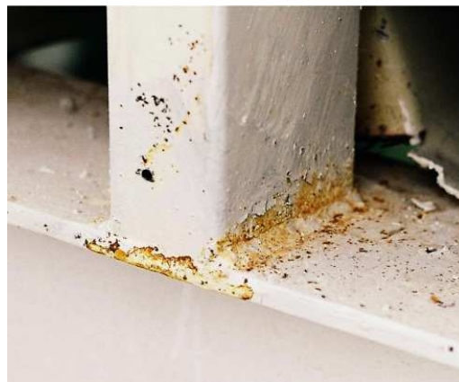
Rys. 6. Połączenie słupka rami z płatwią
