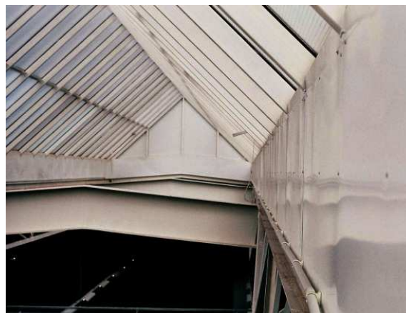
Rys. 3. Widok świetlika od wnętrza hali
