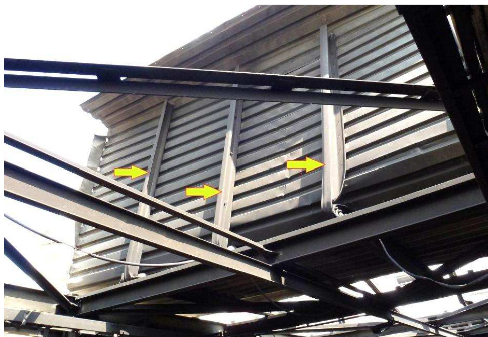
Rys. 4. Odgięte do góry zimnogięte płatwie dachu wraz z obudową w ukośnej galerii transportowej
