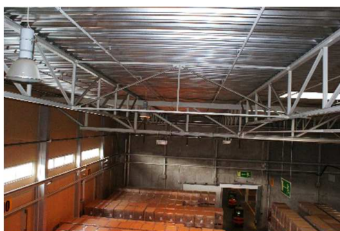
Rys. 7. Stężenia pionowe w hali „H” łączące pary płatwi. Tężniki pionowe, uzupełnione dodatkowymi prętami
