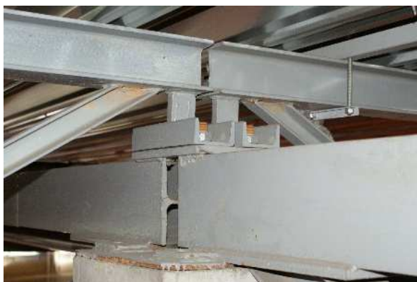
Rys. 6. Oparcie płatwi na dźwigarze głównym
