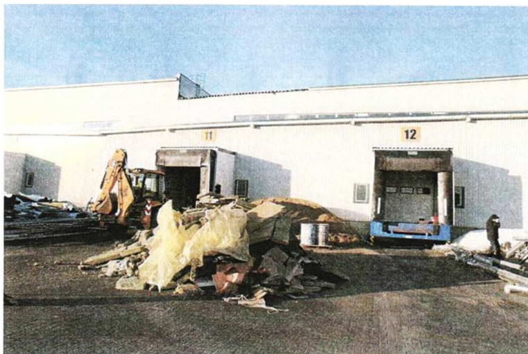
Rys. 1. Część elewacji frontowej na styku hali „H” i „G”
