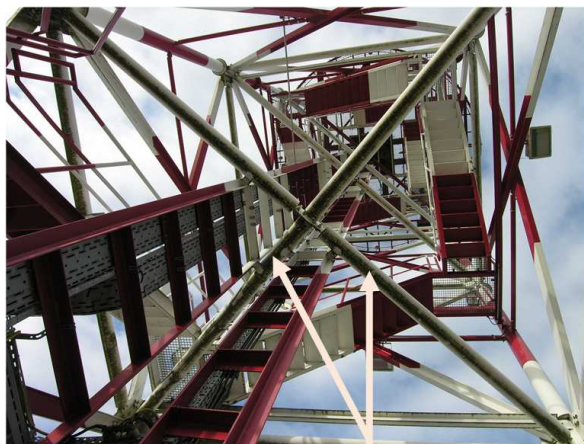
Rys. 4 Wnętrze wieży – przepony i wewnętrznie rozprowadzona klatka schodowa
