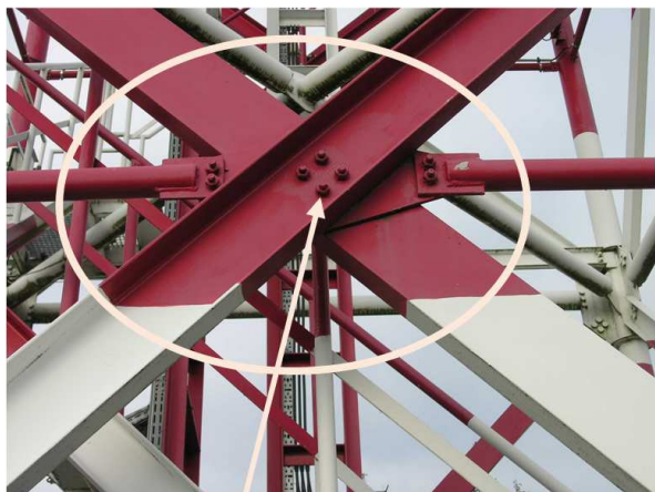
Rys. 3 Węzeł środkowy w ścianie wykratowania – połączenie [200 z rozpórkami
