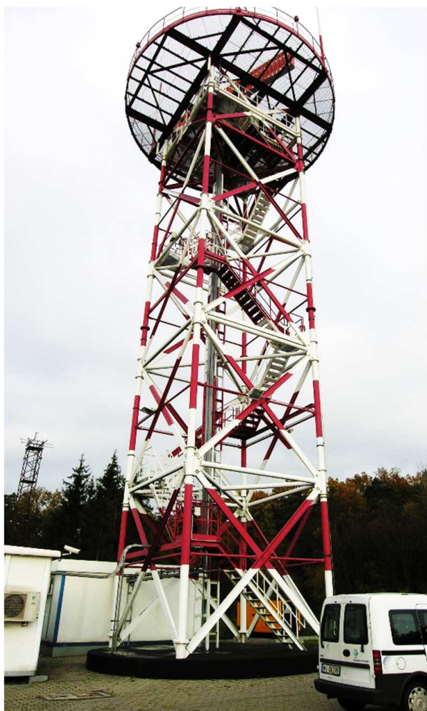
Rys. 1 Widok istniejącej konstrukcji wieży
