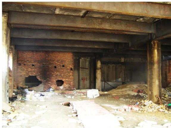
Rys. 6. Widok pierwszej kondygnacji pawilonu południowego
