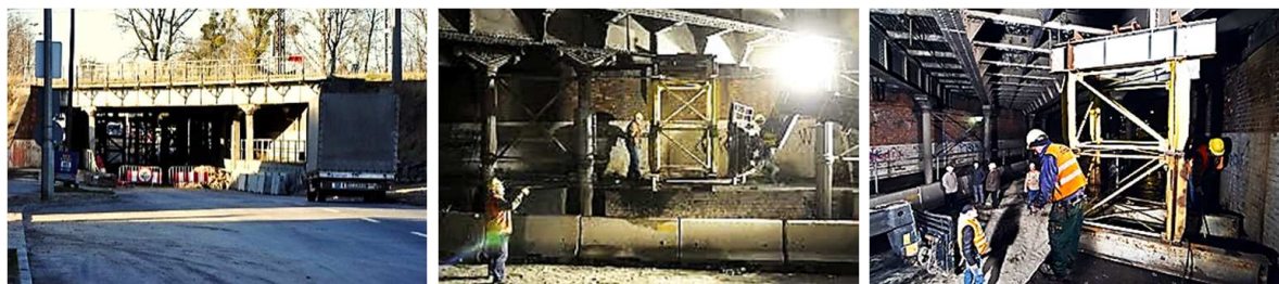
Rys. 9. Zabezpieczenie obiektu – tymczasowe podparcie konstrukcji przęseł [7].
