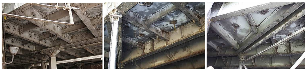
Rys. 2. Widoki od spodu na konstrukcje pomostu
