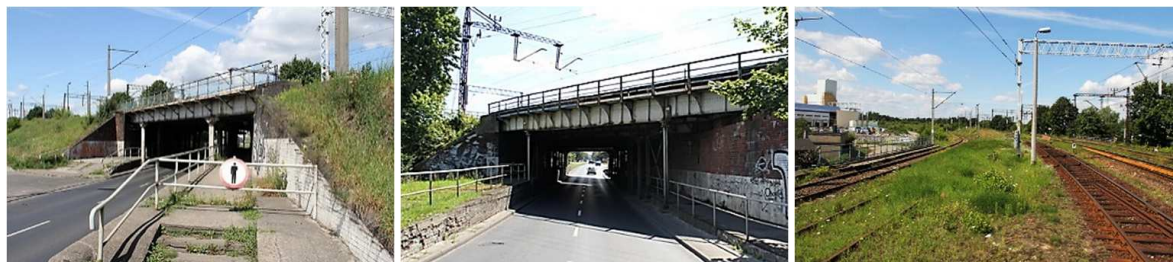
Rys.1. Widoki ogólne wiaduktu
