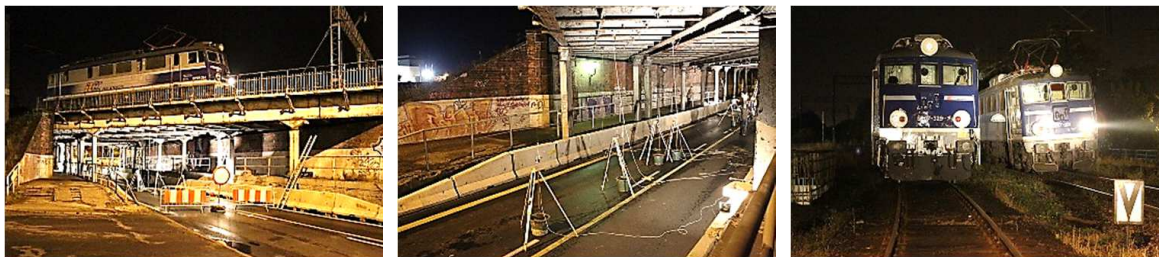
Rys. 6. Próbné obciążenie obiektu
