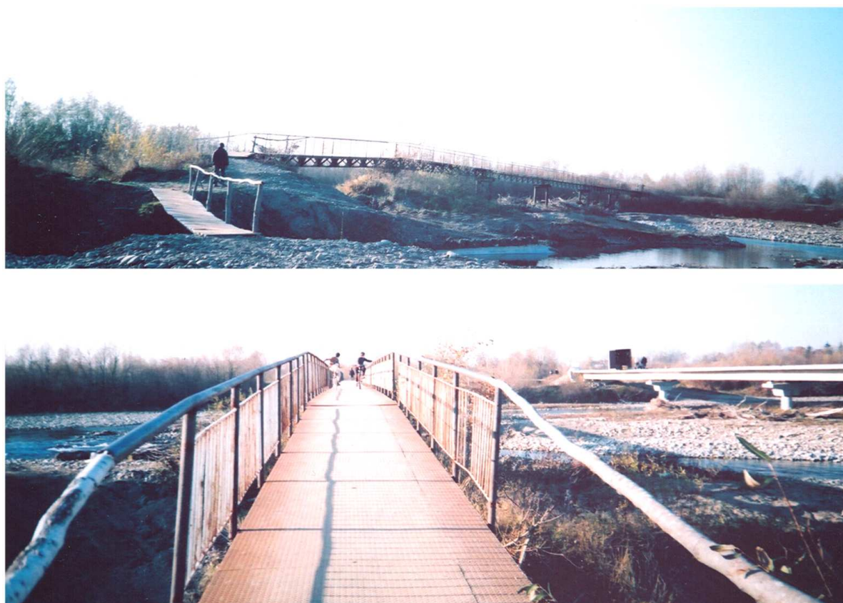
Rys. 1. Widok ogólny istniejącego mostu
