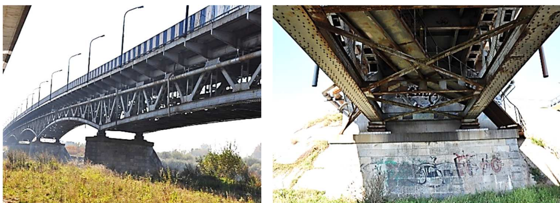
Rys. 1. Stary most przez Wisłę w Sandomierzu (rok budowy – 1953)
