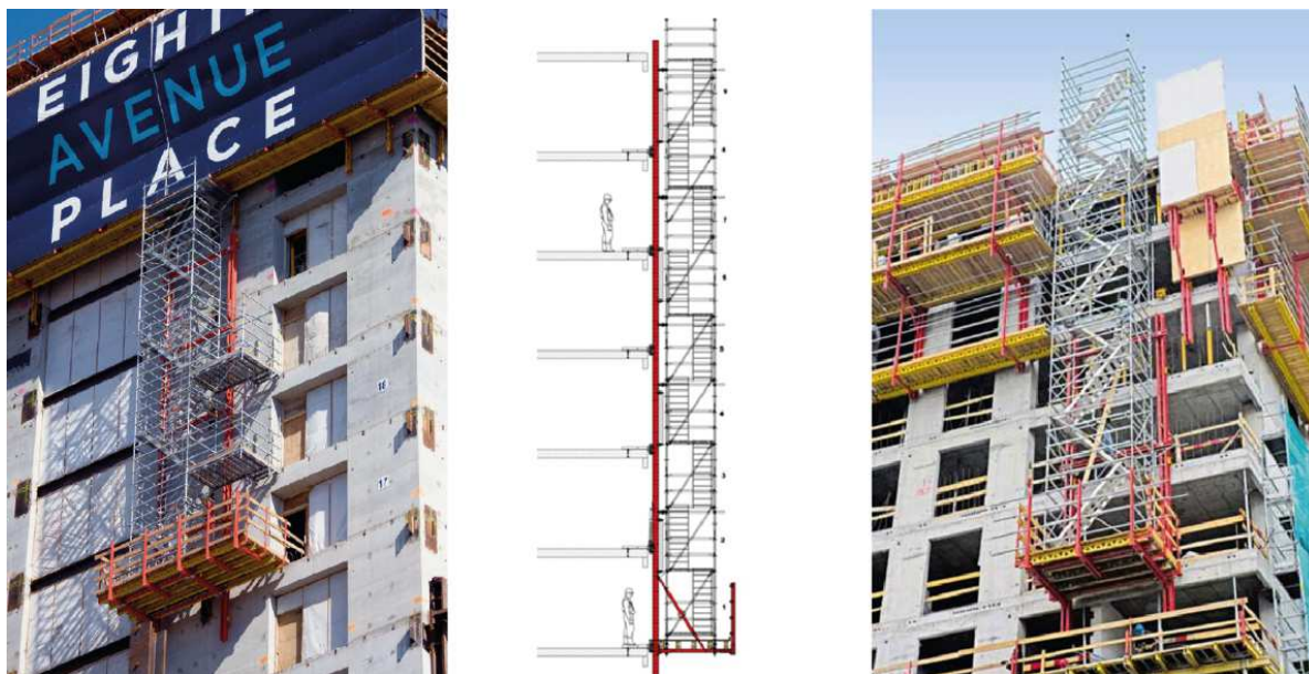
Rys. 15. Zewnętrzne schodnie komunikacyjne na pomostach RCS. Bezpieczny sposób komunikacji w obrębie ostatnich kondygnacji
