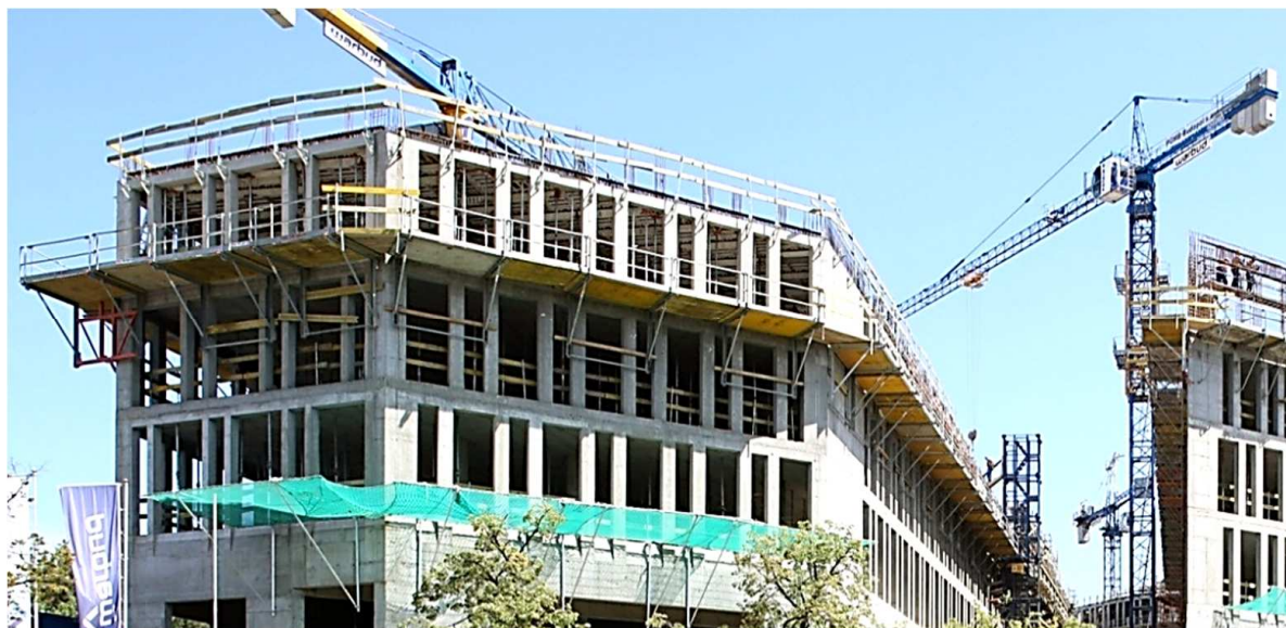
Rys. 11. Pomosty składane FB 180 są dostarczane na plac budowy w stanie gotowym do użycia. Z odpowiednim adapterem stają się pomostami narożnymi. Umożliwiają współpracę z deskowaniami ściennymi do 5,4 m wysokości
