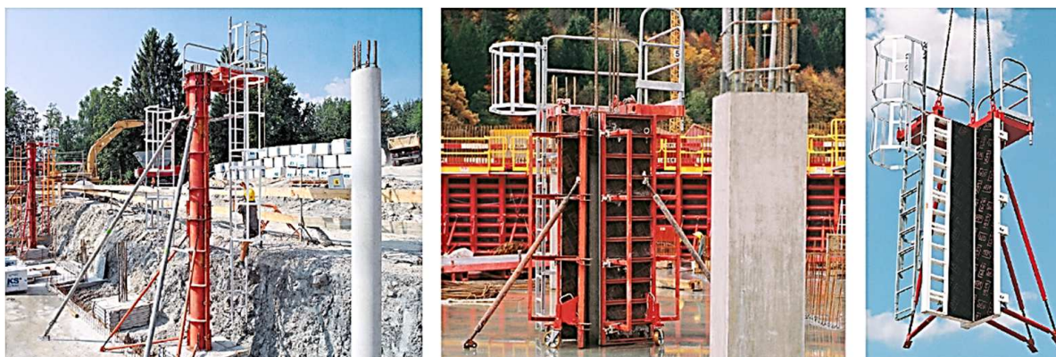
Rys. 14. Deskowania słupowe wyposażone w zintegrowane pomosty betoniarские i drabiny dostępne z osłonami
