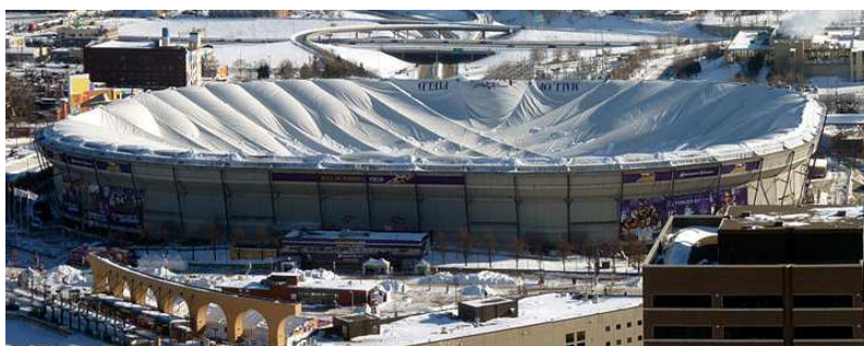
Rys. 4. Powłoka pneumatyczna nad halą Metrodome, która opadła rozerwana po dużych opadach śniegu i silnych wiatrach w 2010 roku, fot. Bobak Ha'Eri [5]
