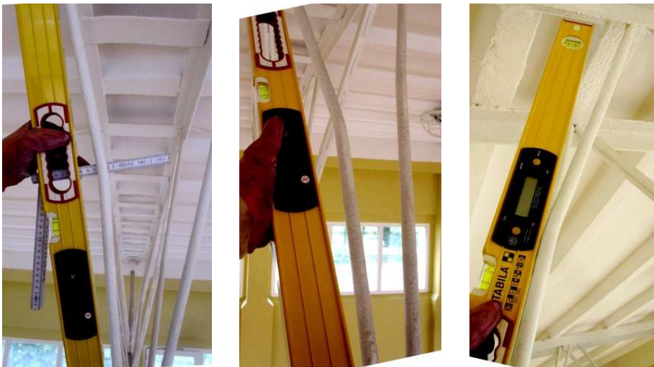
Rys. 4. Przykładowe deformacje okrągłych prętów skratowania
