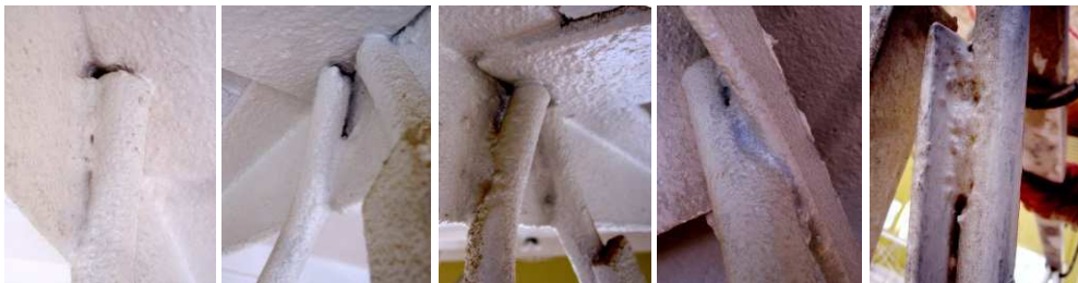
Rys. 7. Przykładowe połączenia pachwinowe w obrębie prętów skratowania ścian bocznych
