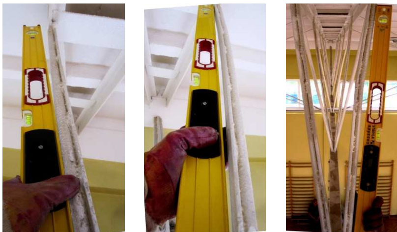
Rys. 5. Przykładowe deformacje prętów skratowania usztywnianych płaskownikami
