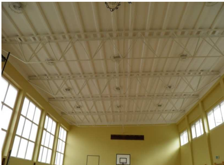
Rys. 1. Wnętrze obiektu z widocznym układem nośnym obiektu i dachu
