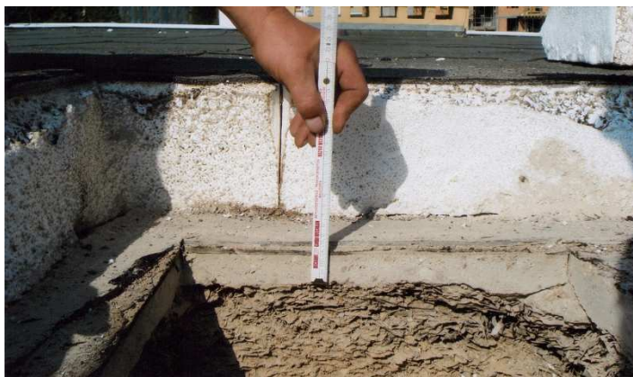
Rys. 2. Warstwy pokrycia dachowego odsłonięte podczas odkrywki
