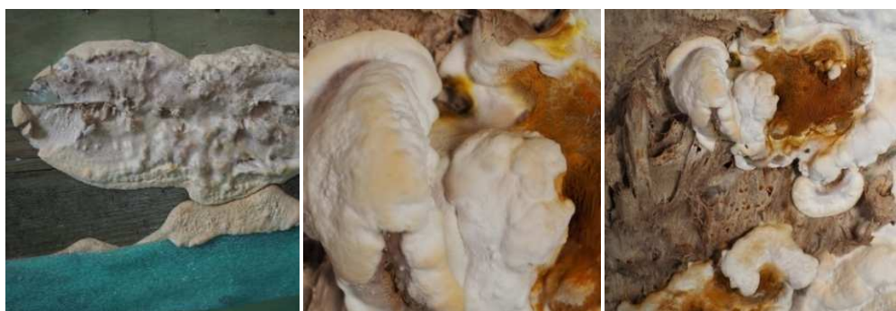
Rys. 6.1–6.3. Ślady grzyba domowego na parterze ( Serpula lacrymans , Wulf.), w różnych stadiach rozwoju
