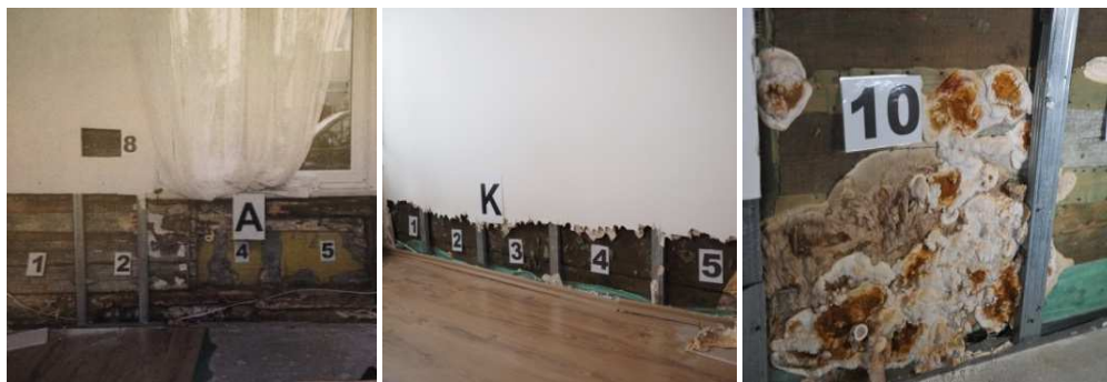
Rys. 5.1–5.3. Wybrane miejsca na parterze porażone przez grzyb domowy właściwy ( Serpula lacrymans )
